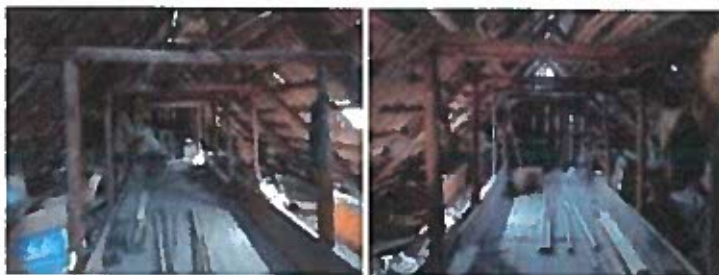
Foto nr.69, 70 Elemente șarpantă, corzi, cu atac de insect xilofage
