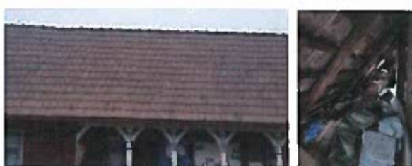
Foto nr.10, 11 Învelitoare confecționată din țigle ceramice
