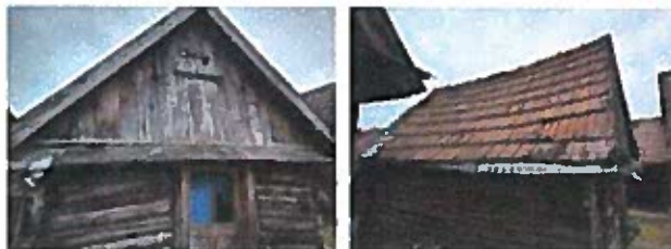
Foto nr.98, 99 Învelitoare confecționată din țiglă, în două ape
