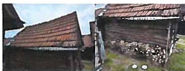
Foto nr.114, 115 Grinzi deteriorate-necesită plătuire
